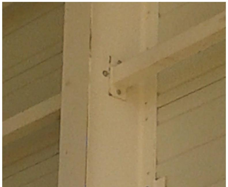
Une poutre buton est constituée d'une barre creuse de section carré C80\*80\*4 finie à froid en acier S235, doublement articulée à ses extrémités.
